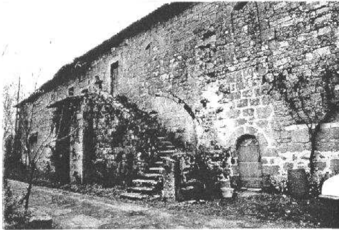
Façade ouest du bâtiment est. Petite porte du cellier.
