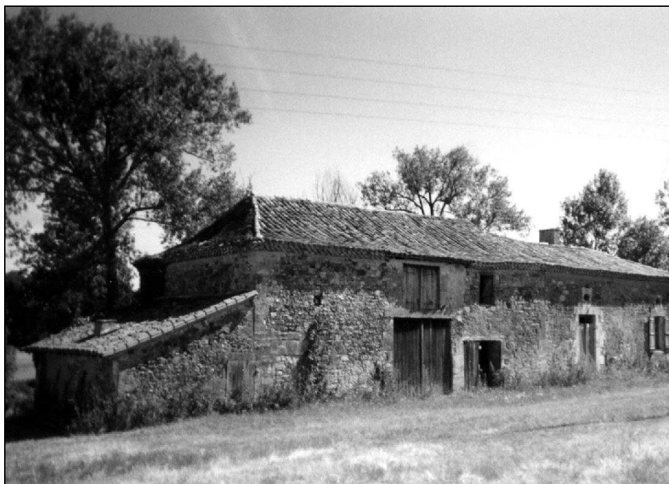
Toitures de tuiles 'canal'
