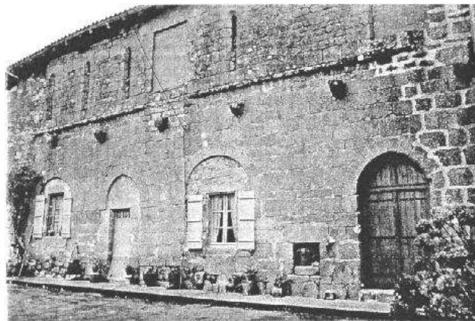
Façade ouest du bâtiment est. Baies de la salle capitulaire Passage du cimetière.
