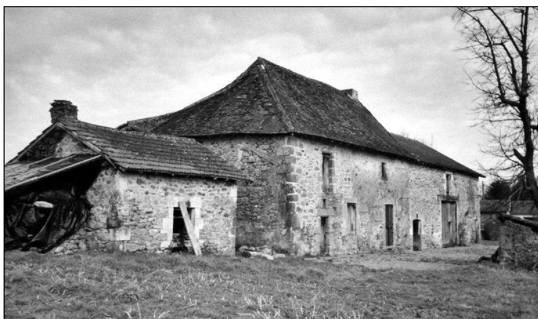
Toiture de tuiles plates.
