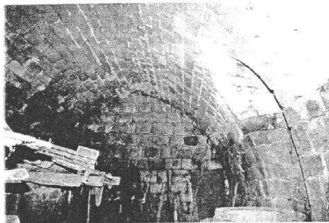
Intérieur du cellier voûté en berceau brisé
